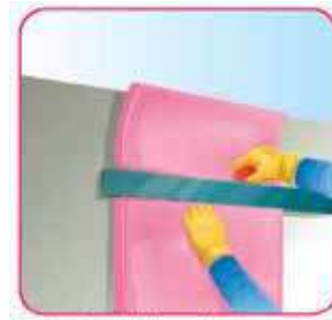
Corte el material excedente con una navaja o cuchillo con filo.
